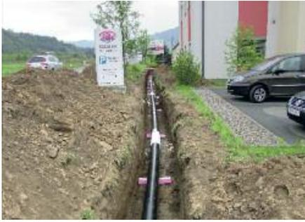
Die Anschlüsse für die „Saubere Wärme“ erforderten massive Grabungsarbeiten.
